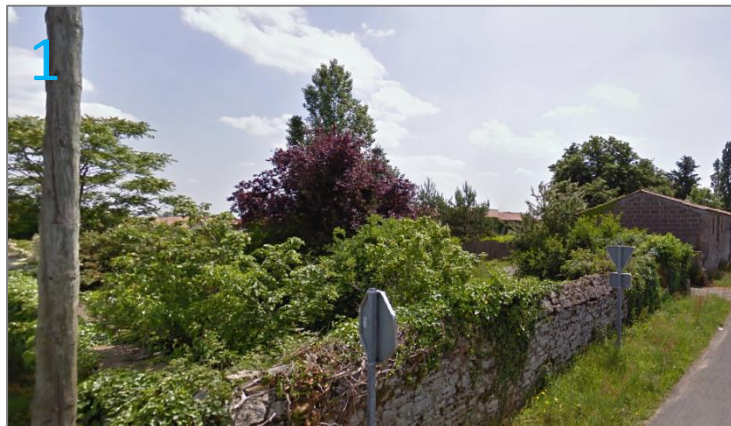
Mur à conserver sous réserves (sécurité, visibilité)
