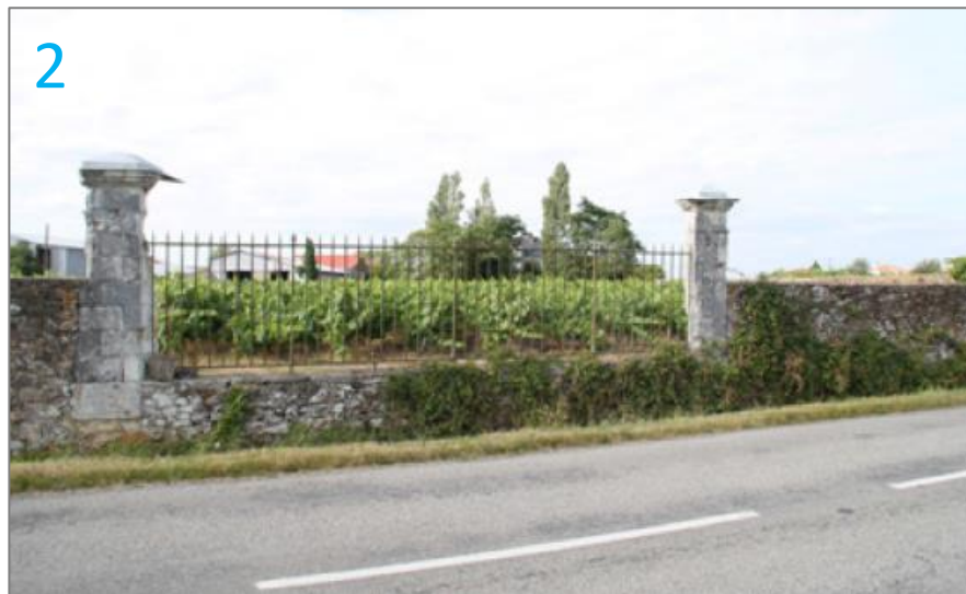
Mur avec grille à conserver sous réserves (sécurité, visibilité)
