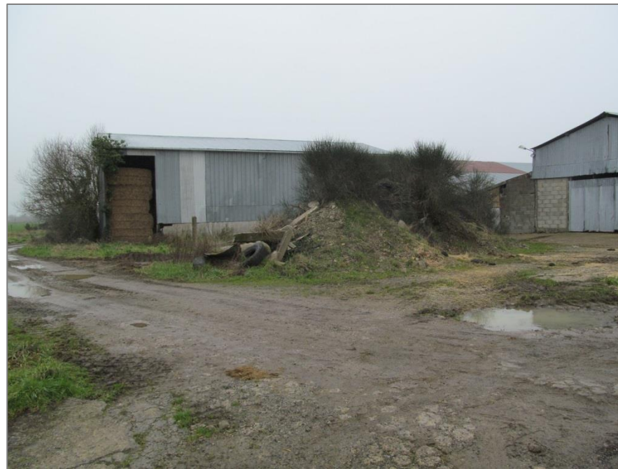
Bâtiments de stockage
