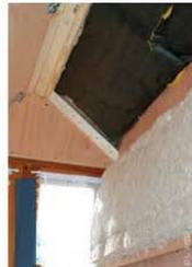
Construction d'un caisson isolé
